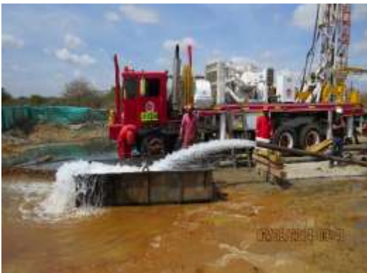
Figura 7. Pozo Exploratorio Uribia Caudal 70 Ips.
