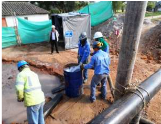
Figura 13. Prueba de Bombeo Pozo Exploratorio SGC-Firavitoba Caudal 12 lp
