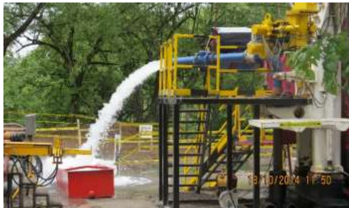
Figura 10. Pozo Exploratorio Puerto Caldas-Pereira Caudal 100 Ips
