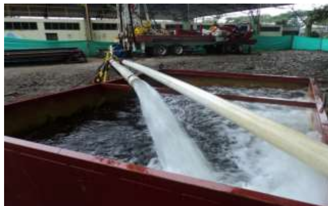
Figura 11. Pozo Exploratorio Puerto Caldas-Pereira Caudal 50 Ips
